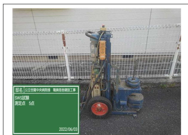
SWS測定状況 測定点5 最終貫入状況
