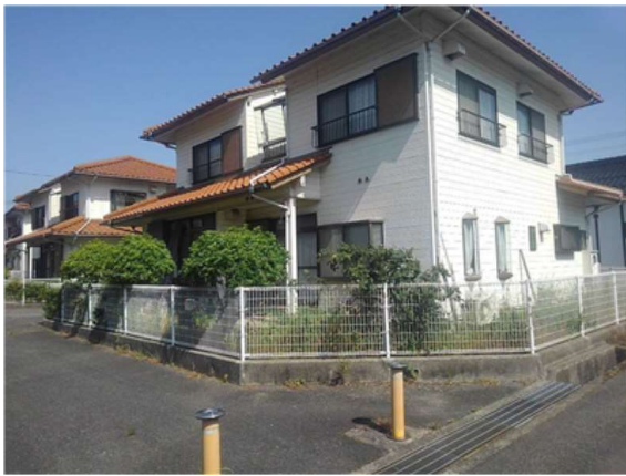
現場状況 (地盤調査)
