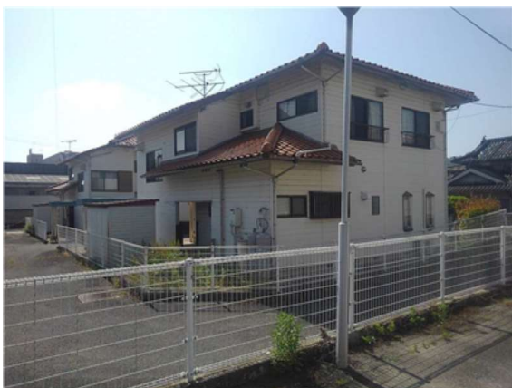
現場状況 (地盤調査)
