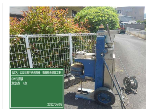
SWS測定状況 測定点4 調査前
