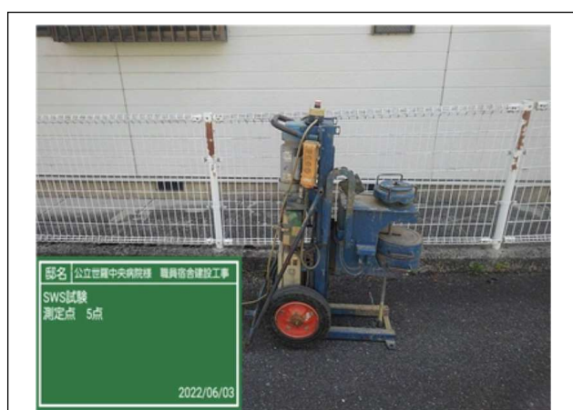
SWS測定状況 測定点5 調査前
