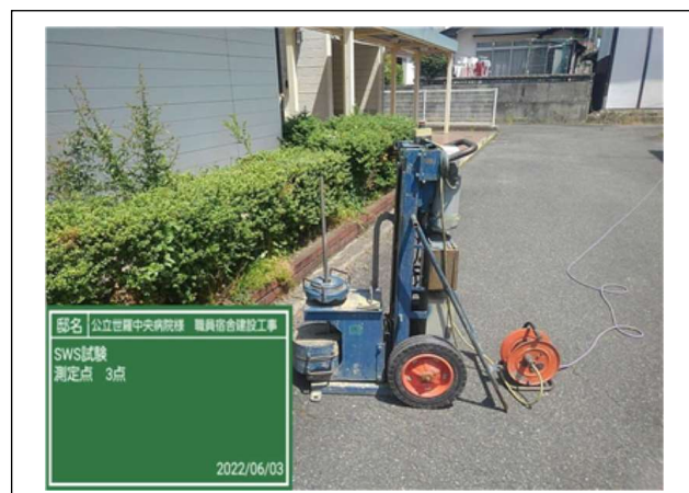
SWS測定状況 測定点3 最終貫入状況
