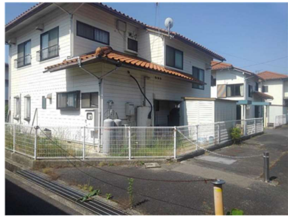
現場状況 (地盤調査)
