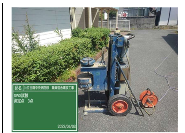
SWS測定状況 測定点3 調査前
