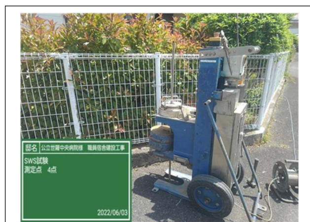
SWS測定状況 測定点4 最終貫入状況
